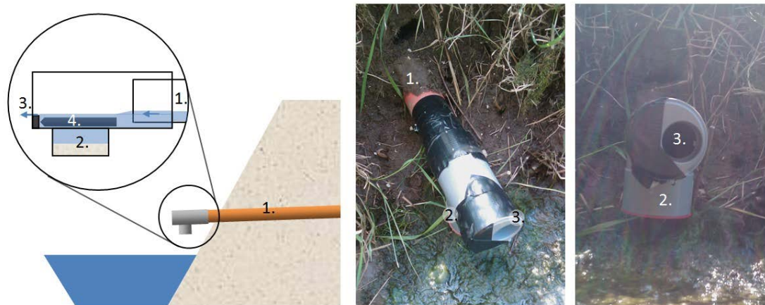
Figuur 3.11 Meten aan drainafvoer; 1. Drainbuis; 2. Zandvang; 3. Uitstroomopening; 4. Diver.
